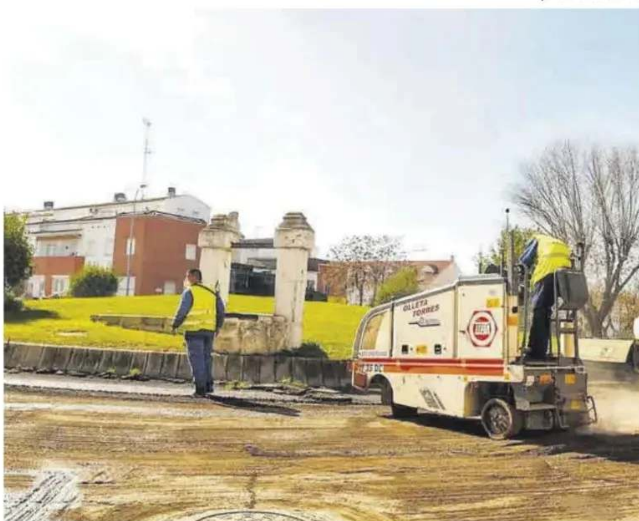
Asfaltado en una rotonda de la capital extremeña.
